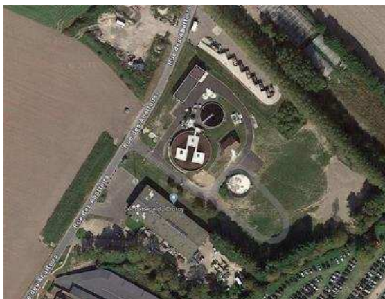
Photo aérienne de la station d'épuration
