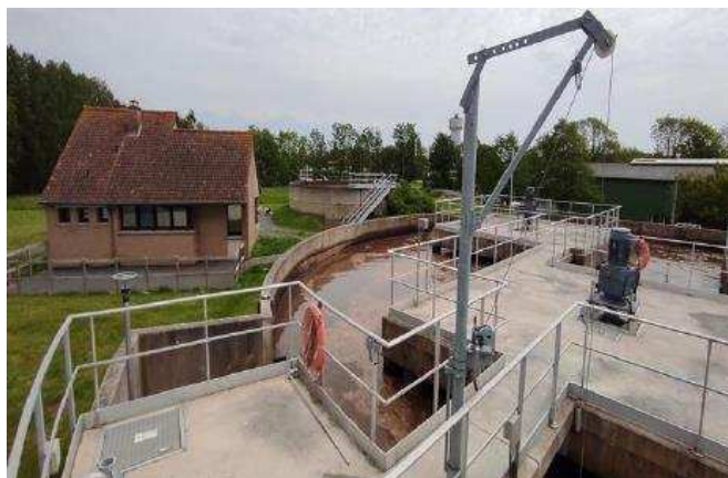
Photo de la station d'épuration
