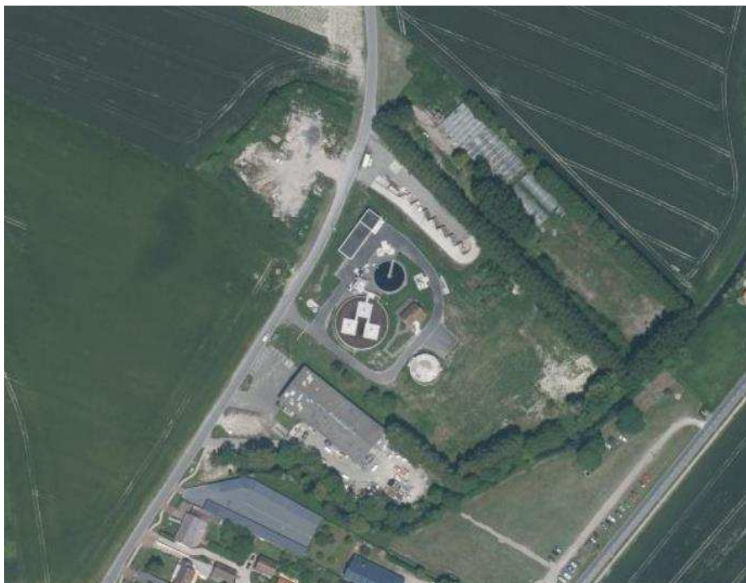
Photo aérienne de la station d'épuration du Crotoy
