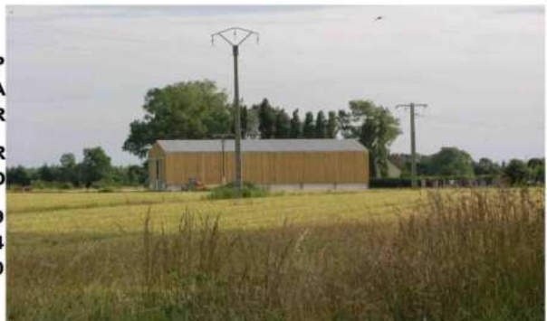
Des choix de matériaux et de couleurs permettant une bonne intégration paysagère de ce bâtiment d'activité
