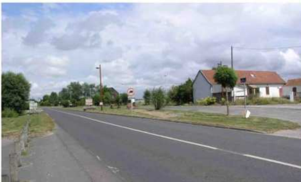
Lecture difficile de la structure urbaine, densité peu marquée, largeur de l'espace public. Surface en eau des carrières à l'arrière plan.
