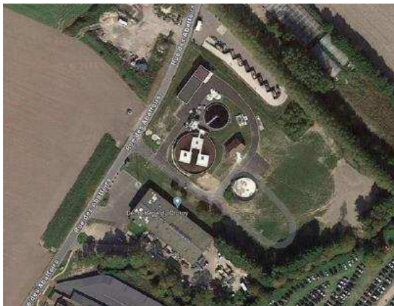
Photo aérienne de la station d'épuration
