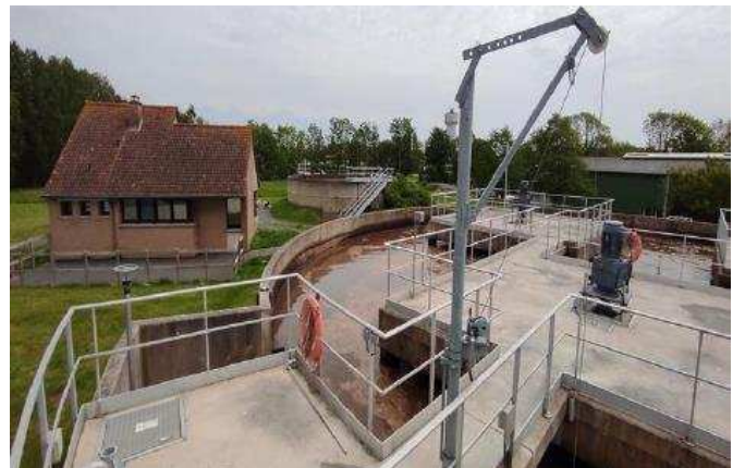
Photo de la station d'épuration
