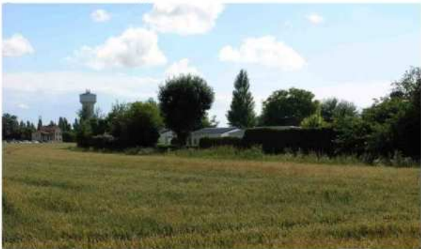
Vue latérale précédant le carrefour giratoire, dominée par trois éléments : le château d'eau, le camping, la gare du chemin de fer touristique et son aire de stationnement
