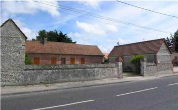
Rue Principale : un bâti patrimonial...
