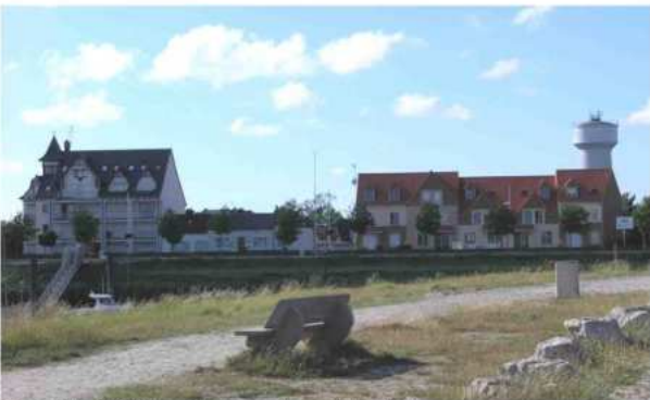
Constat similaire, ici sur la digue Mercier
